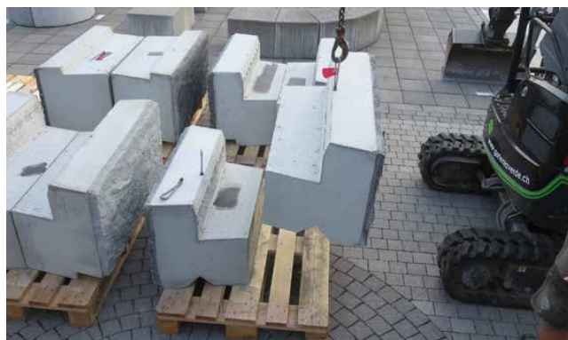
Illustration 21 : douilles de transport M16 montées en usine
