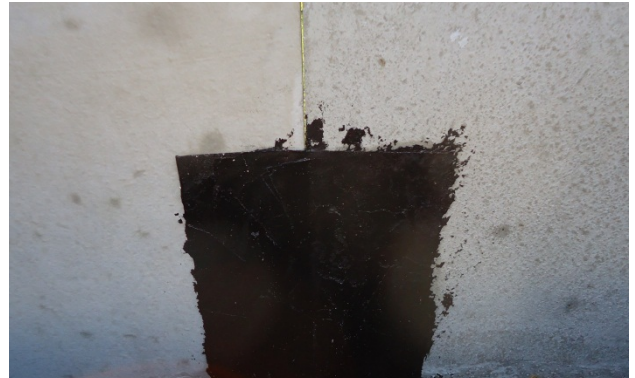
Bild 33: Abdichten der Fugen
