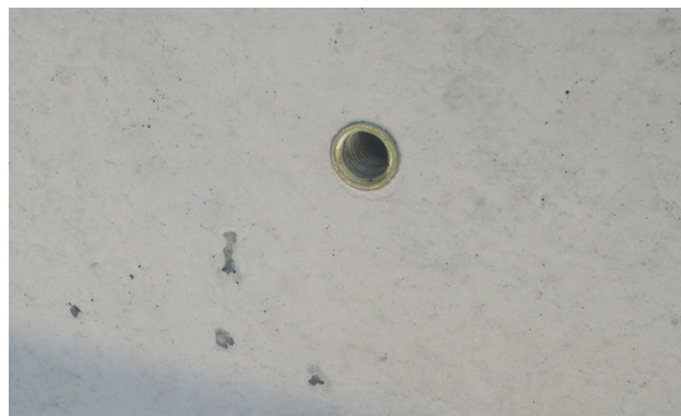
Bild 20: Werkseitig eingebaute Versetzhülse
