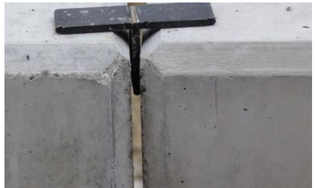
Bild 32: Optimale Fugen nach der Versetzung
