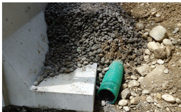
Bild 28: Einbau einer Sickerleitung mit Sickerpackung
