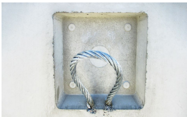
Bild 24: Werkseitig eingebaute Versetzschlaufen
