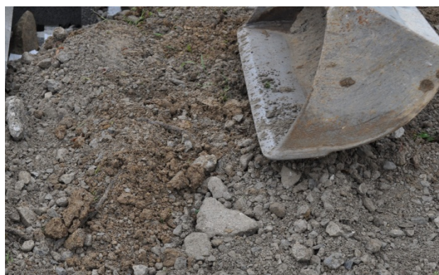
Bild 28: Lagenweises Einbringen von geeigneten Hinterfüllmaterial
