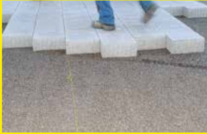
Einschnürung der Verlegeeinheit
