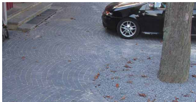
Adaptation à une ouverture pour un arbre
