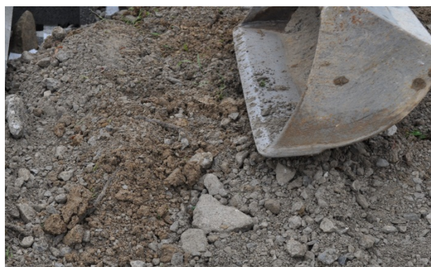
Bild 28: Lagenweises Einbringen von geeigneten Hinterfüllmaterial
