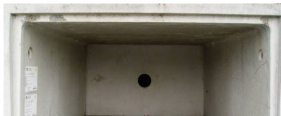
Bild 28: Lichtschachtsohle mit eingebautem Boden
