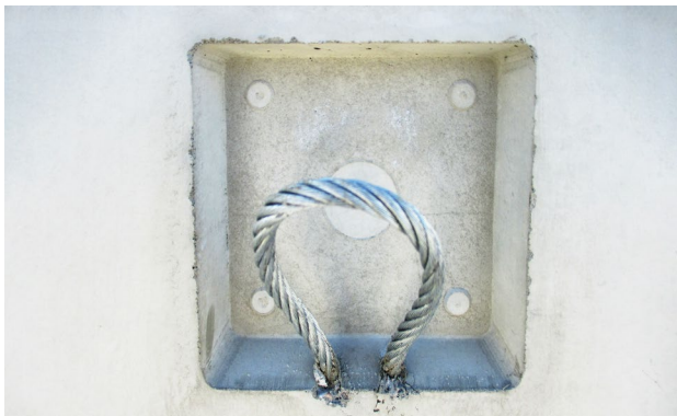
Bild 30: Werkseitig eingebaute Seilschlaufen
