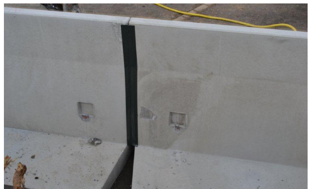
Bild 40: Abdichten der Fugen
