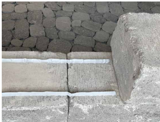
Illustration 1 : Encollage d'une rangée
