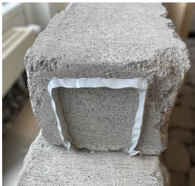
Illustration 2 : Encollage d'une tête de brique
