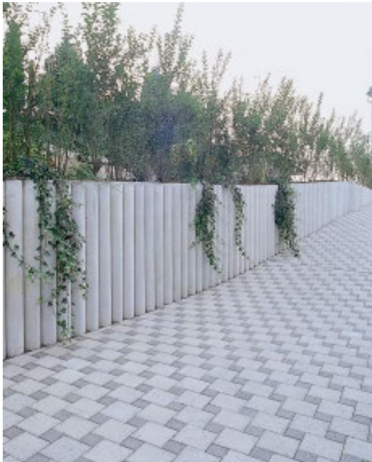
Bild 16: Betonhohlpalisaden als Hangsicherung
