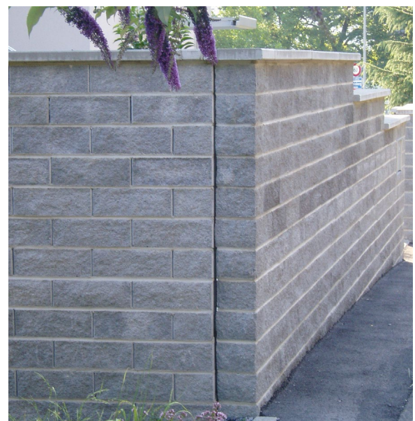
Bild 41: Dilatationsfuge (Produktneutral)
