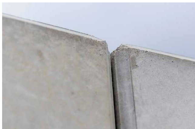
Joints entre éléments
