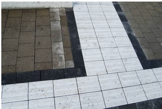
Bild 35: Optimale Fugen bei Steinen H = 6 cm
