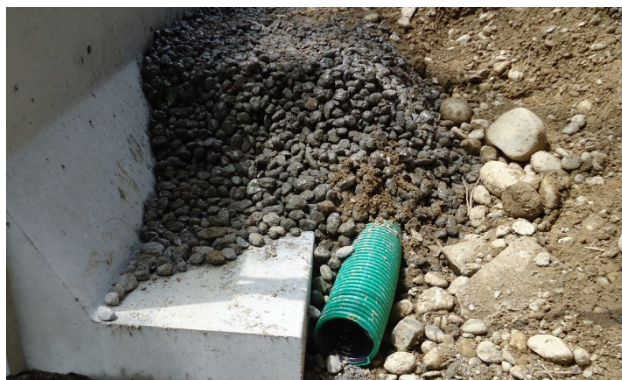
Bild 34: Einbau einer Sickerleitung
