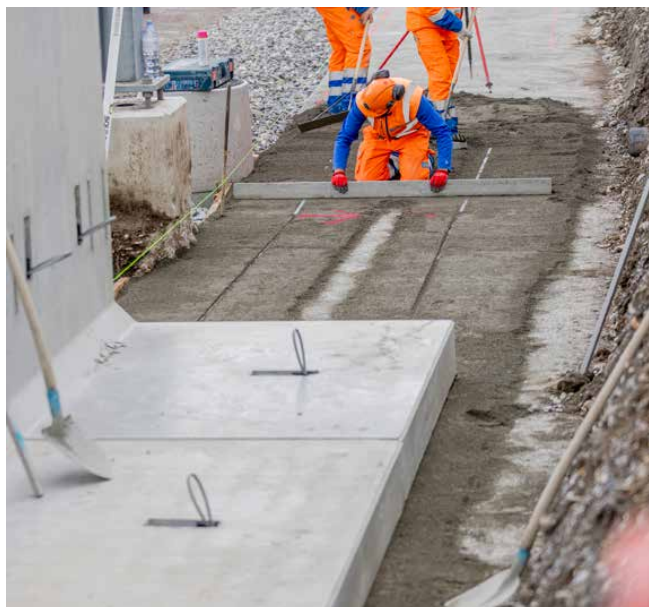
Pose des éléments sur semelle filante
