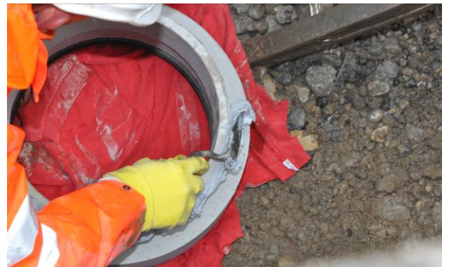
Bild 9: Auftragen der Klebmasse auf den Schaft
