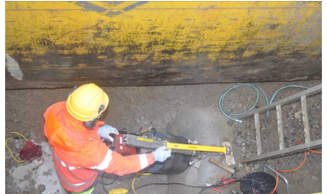
Bild 6: Korrekt montiertes Kernbohrgerät
