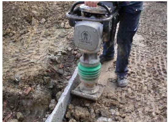
Bild 22: Verdichten mit Vibrostamper
