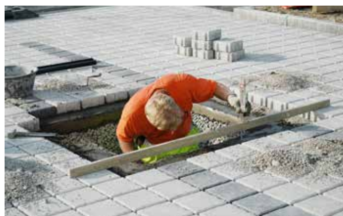
Erstellen eines Auflagers auf Fundamentrahmen
