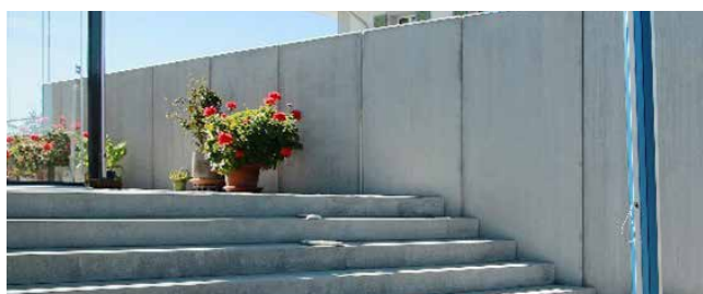
Éléments en équerre GRANDE dans les aménagements extérieurs
