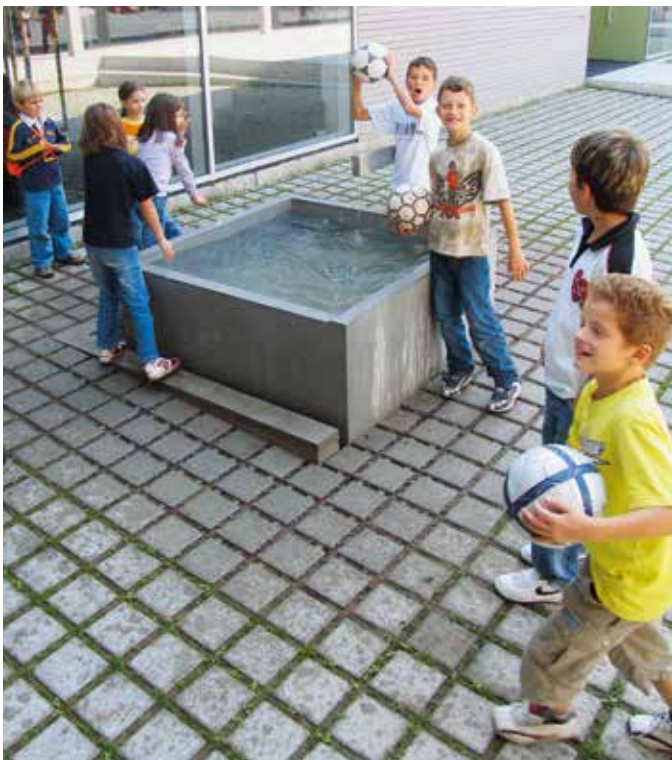
Pausenplatz mit Rasenfugenstein
