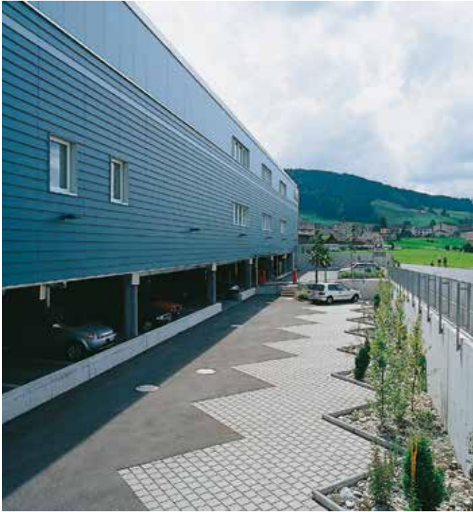
Versiegelte Fläche, kombiniert mit Versickerung
