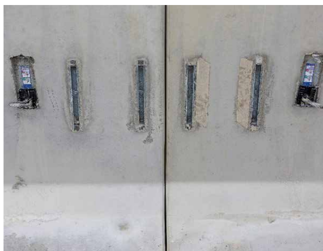
Rails Halfen comme système d'assemblage
