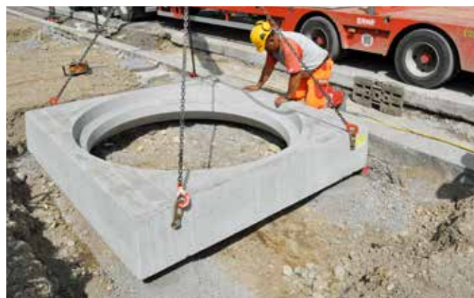
Versetzen des COPAL QUADRO Basiselementes
