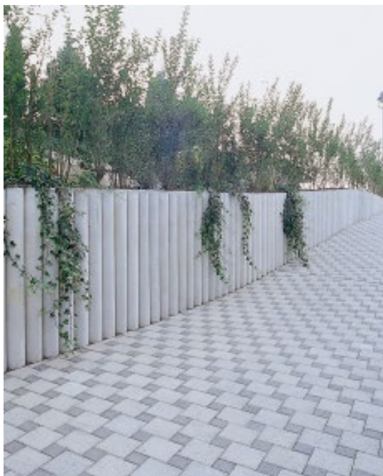
Bild 16: Betonhohlpalisaden als Hangsicherung
