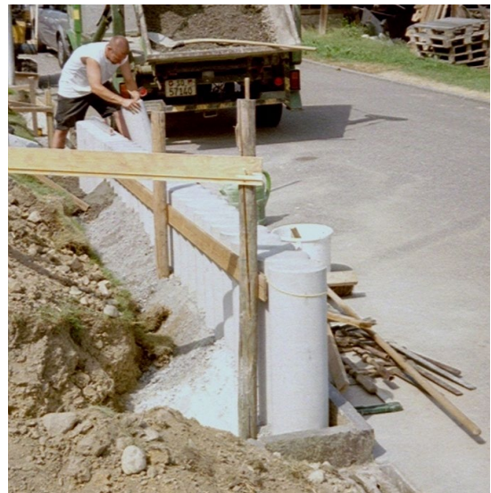
Bild 13: Richtplatte als Verlegehilfe für den Einbau von Palisaden
