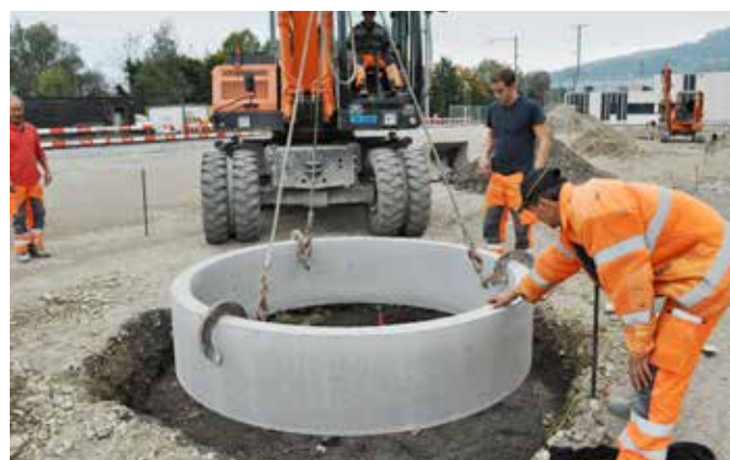
Versetzen des TREETUB Betonrohres auf das Streifenfundament
