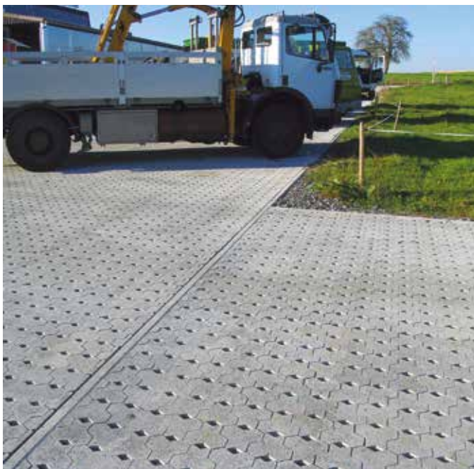
Parkfläche mit SIX SILENTA Ökostein (Splittfugen)
