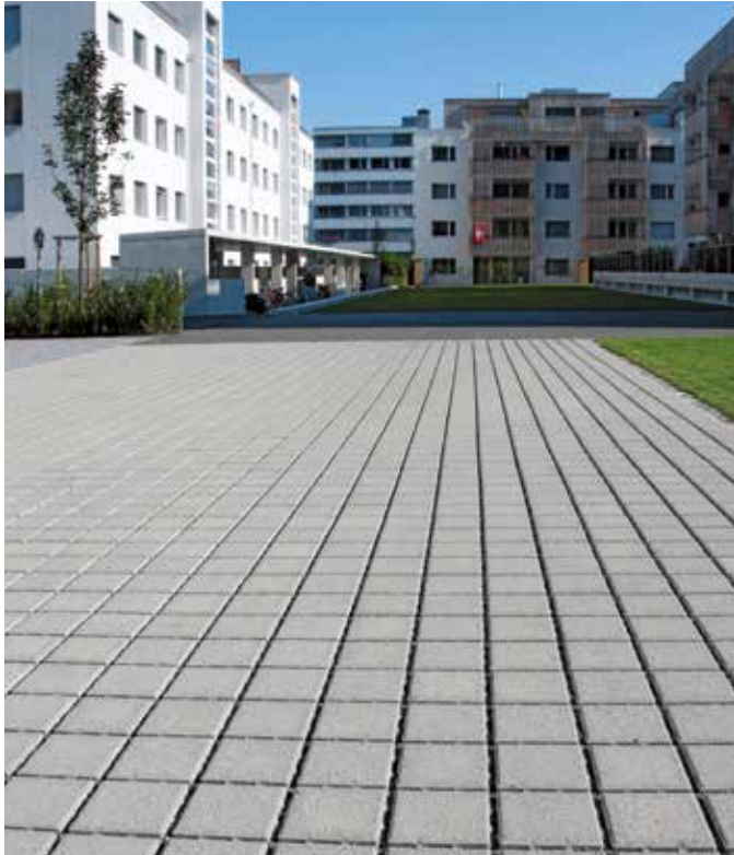
Parkfläche mit SPLITT Ökostein
