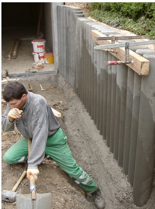
Bild 15: Einbetonieren der Palisaden
