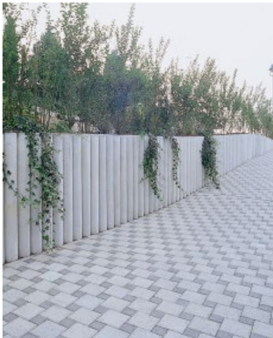
Bild 16: Betonhohlpalisaden als Hangsicherung
