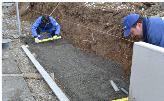
Bild 33: Erstellen des Streifenfundamentes
