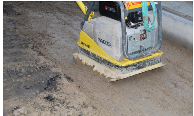
Bild 35: Verdichten nur mit leichten Verdichtungsgeräten
