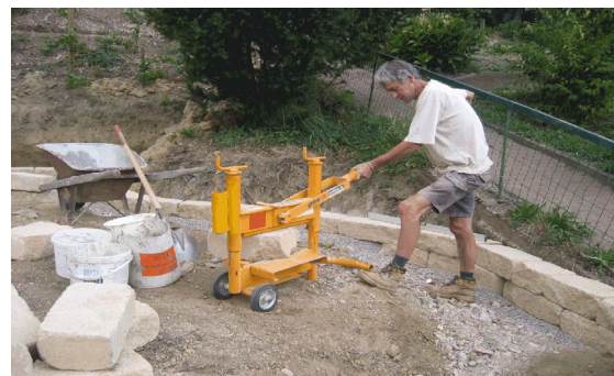
Bild 35: Arbeiten mit Steinspalter
