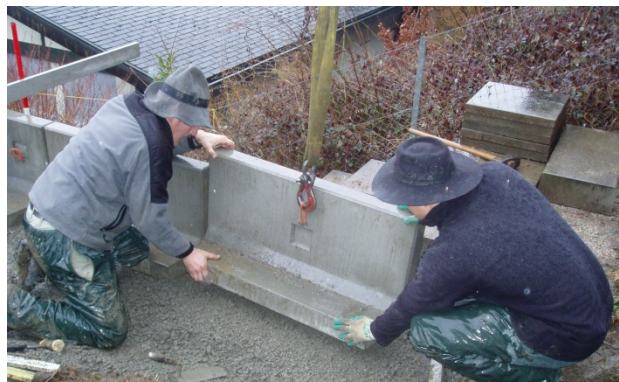
Bild 23: Versetzen der Winkelplatte auf ein Streifenfundament
