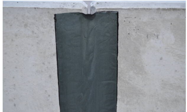
Bild 27: Abdichten der Fugen
