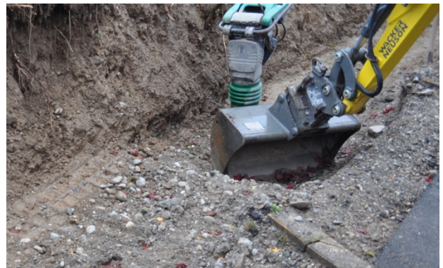
Bild 20: Erstellen der Sauberkeitsschicht
