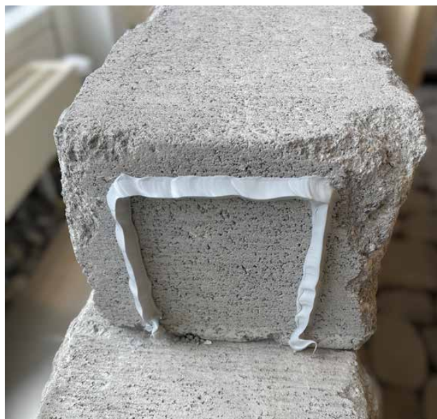
Illustration 2 : Encollage d'une tête de brique
