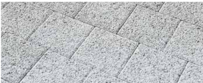
Versickerung durch wasserdurchlässige Pflastersteine (Sickersteine)
