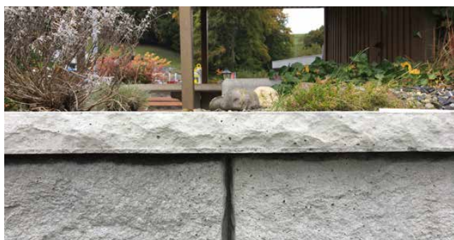
Illustration 25 : couvertines posées
