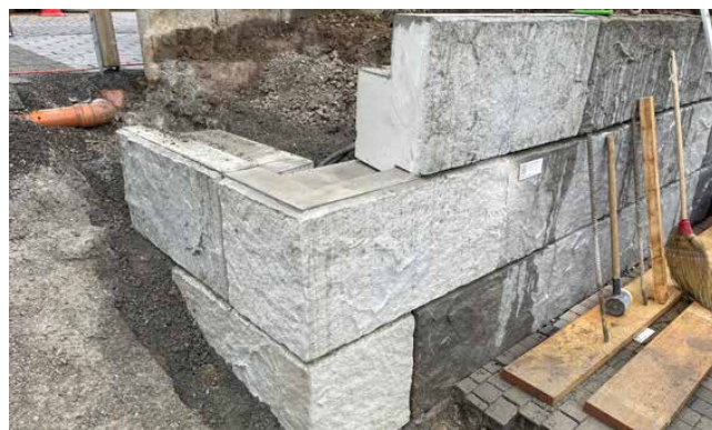
Illustration 24 : pose des éléments d'angle
