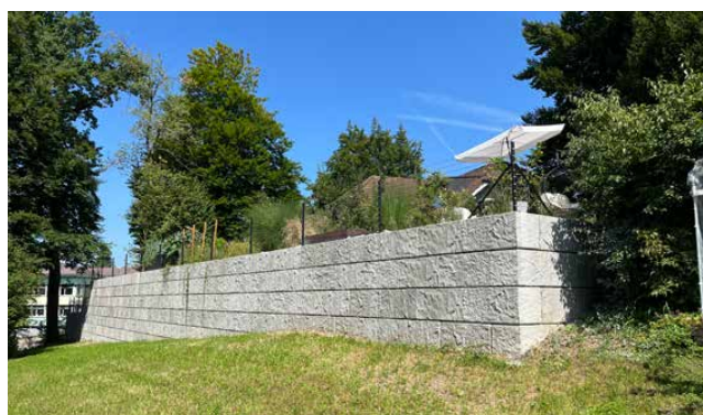
Illustration 26 : garde-corps sur le couronnement d'un mur
