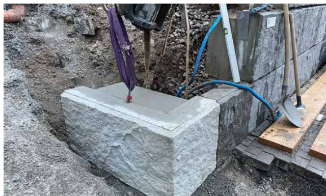
Illustration 22 : briques initiales avec semelle filante sans mortier-colle
