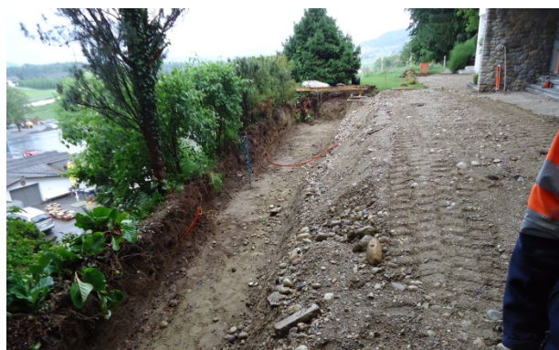
Bild 22: Erstellen der Sauberkeitsschicht
