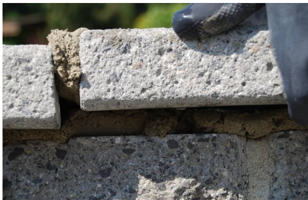
Bild 63: Versetzen der Abdeckplatten
