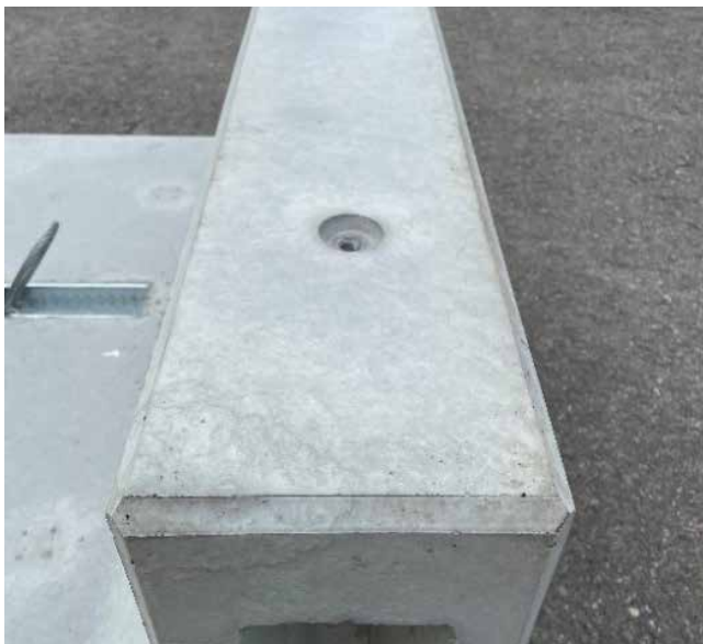
Werkseitig eingebaute Gewindehülsen
