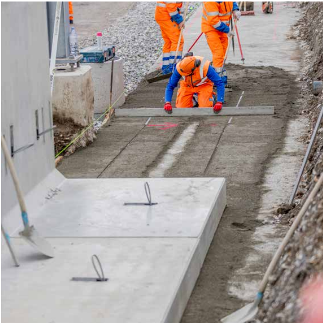
Erstellung des Streifenfundamentes
