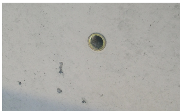
Bild 20: Werkseitig eingebaute Versetzhülse
