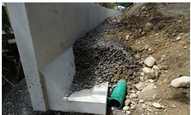
Bild 24: Einbau einer Sickerleitung
