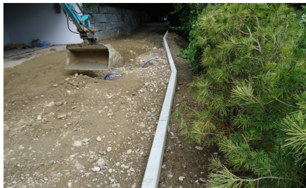
Bild 29: Lagenweises Einbringen von geeignetem Hinterfüllmaterial
