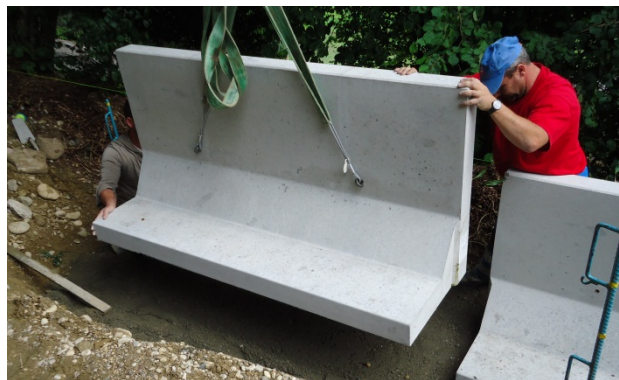
Bild 25: Versetzen der Winkelplatte auf ein Streifenfundament
