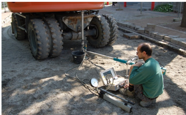
Bild 13: Kontrolle der Tragfähigkeit mit Me-Messungen
