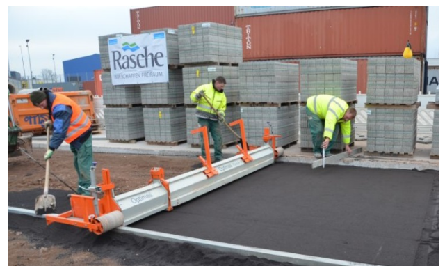
Bild 19: Mischgut abziehen
