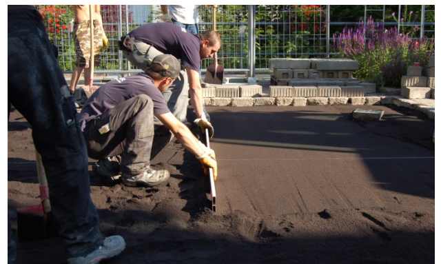
Bild 18: Mischgut abziehen
