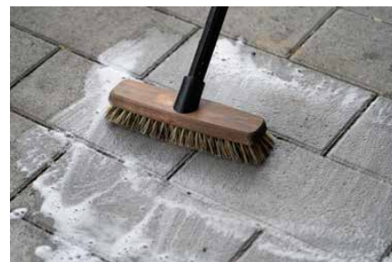
Reinigungsmittel auftragen
