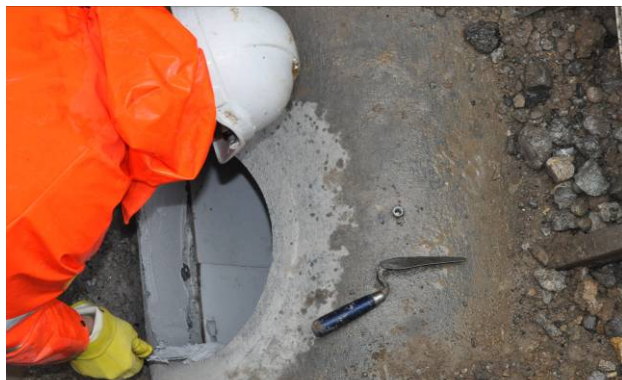
Bild 10: Klebmasse auf die Bohrlochwandung auftragen
