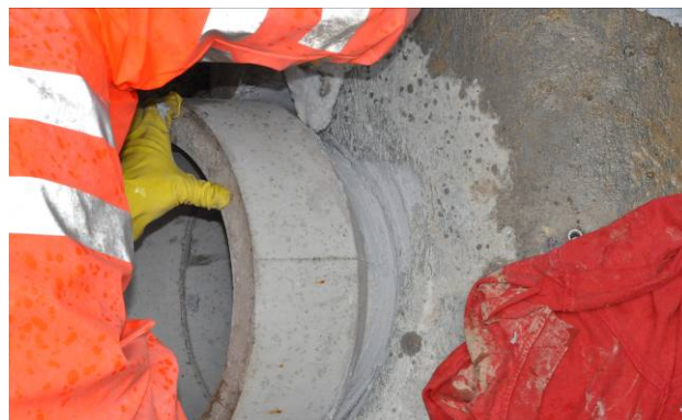
Bild 13: Bilden der äusseren Kehlkannte
