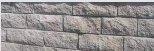
Mauersteine als Hangsicherung, trocken verlegt oder mit Mörtelschicht
