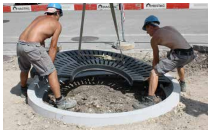
Versetzen der Gussroste
