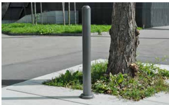
Stammschutzpfahl für sämtliche Betonabdeckungen
