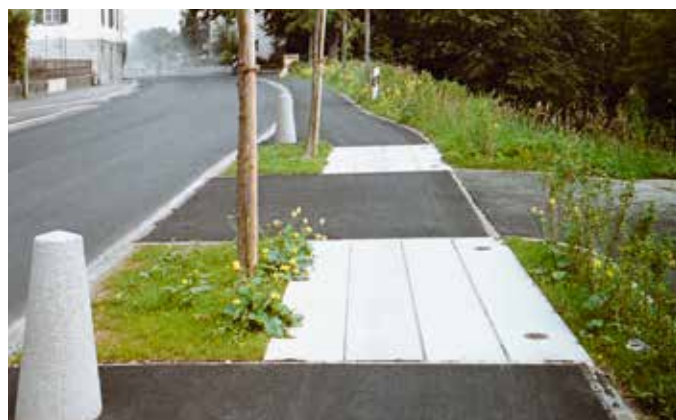
Wurzelbrücke mit Wehrsteinen als Anfahrtschutz
