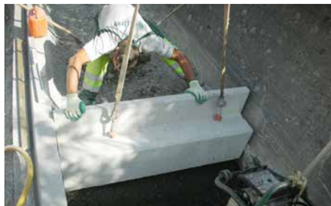
Versetzen des F+F Fertigfundamentes
