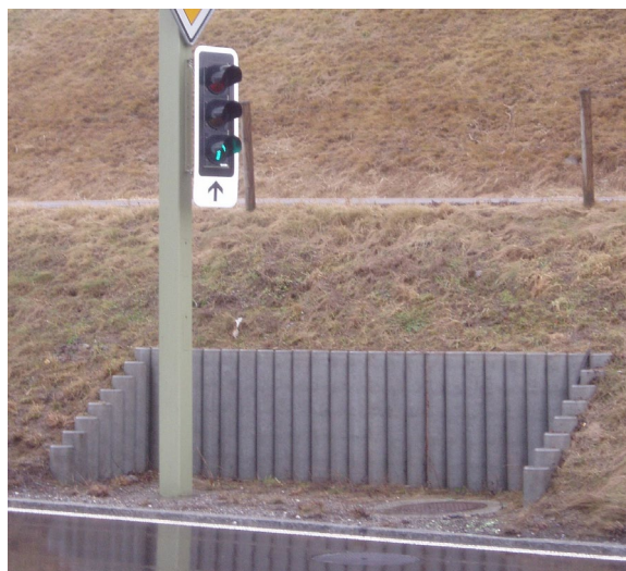
Bild 4: Palisaden als Hangsicherung
