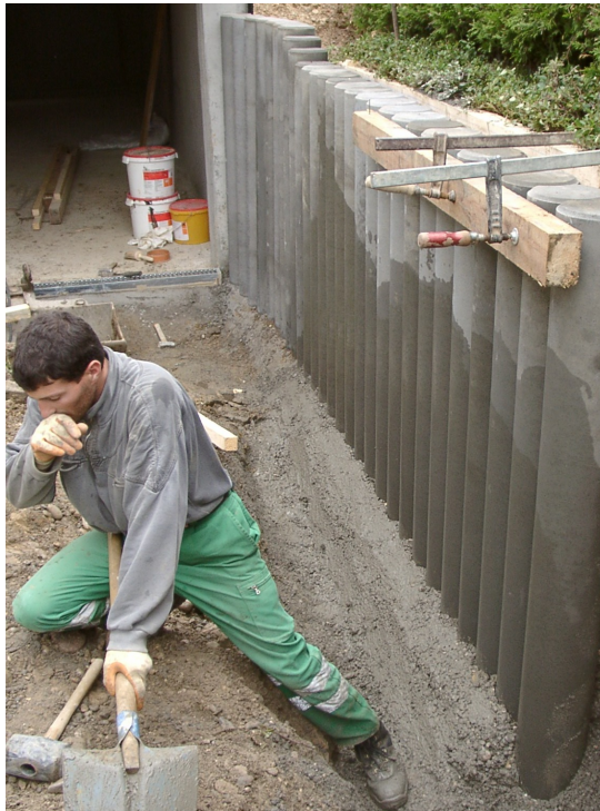
Bild 15: Einbetonieren der Palisaden
