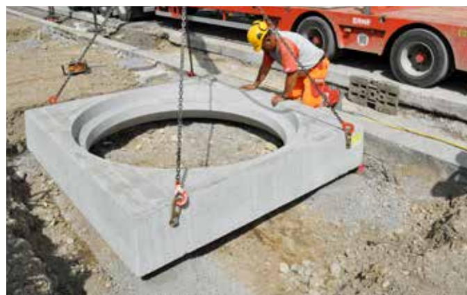
Versetzen des COPAL QUADRO Basiselementes
