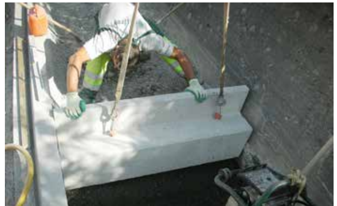
Versetzen des F+F Fertigfundamentes
