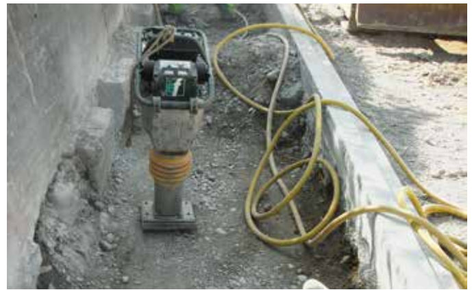
Sohle für die Versetzung der Fundamente
