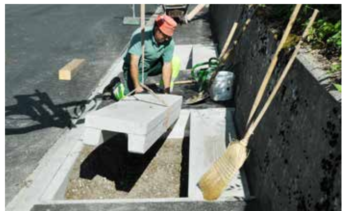
Versetzen der F+F Abdeckelemente
