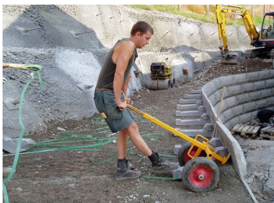
Bild 17: LOCK+LOAD Versetzwagen
