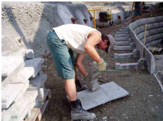
Bild 15: Frontplatte mit Anker verbinden
