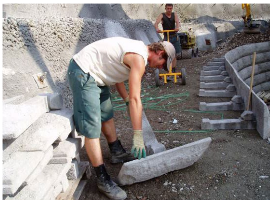
Bild 16: Frontplatte mit Anker verbinden
