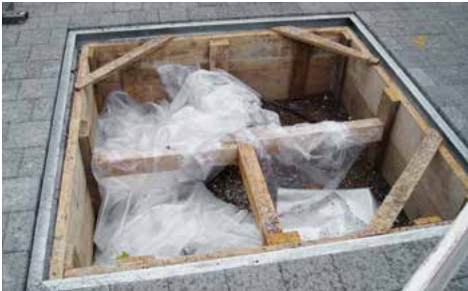
Eingebauter Stahlrahmen als Baumkranz
