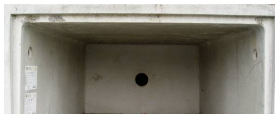
Bild 28: Lichtschachtsohle mit eingebautem Boden
