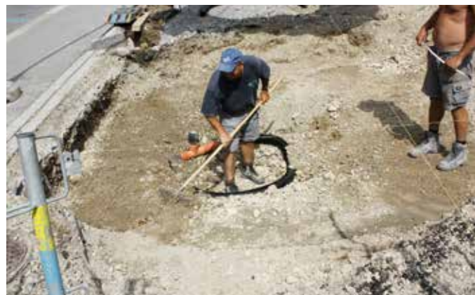
Erstellen der Auflageflächen
